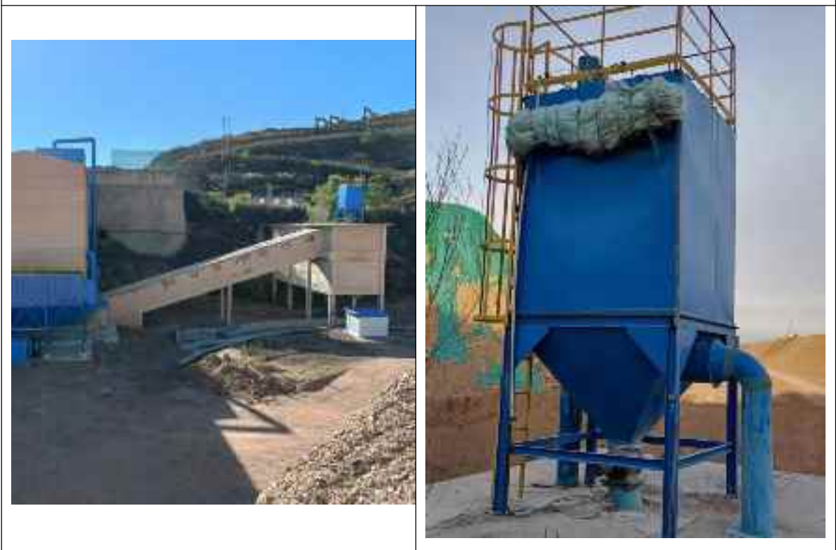
粉矿仓治理措施
